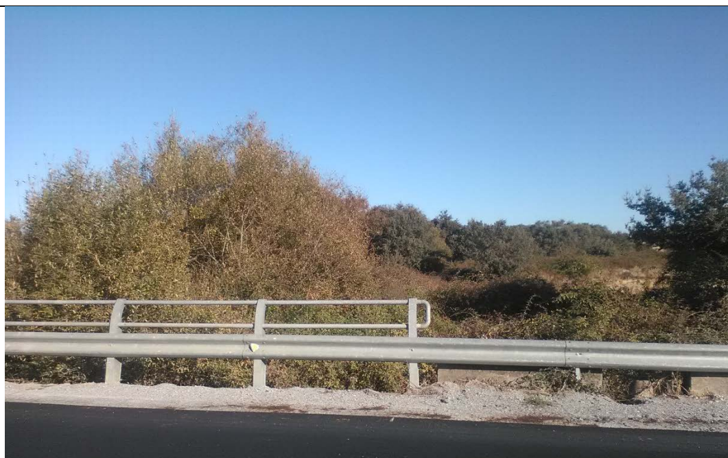
Arroyo burdalo a su paso por la carretera CC24.1
